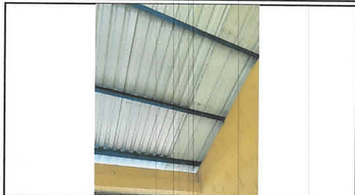
Foto 2: Mantenimiento a Estructura de metal
